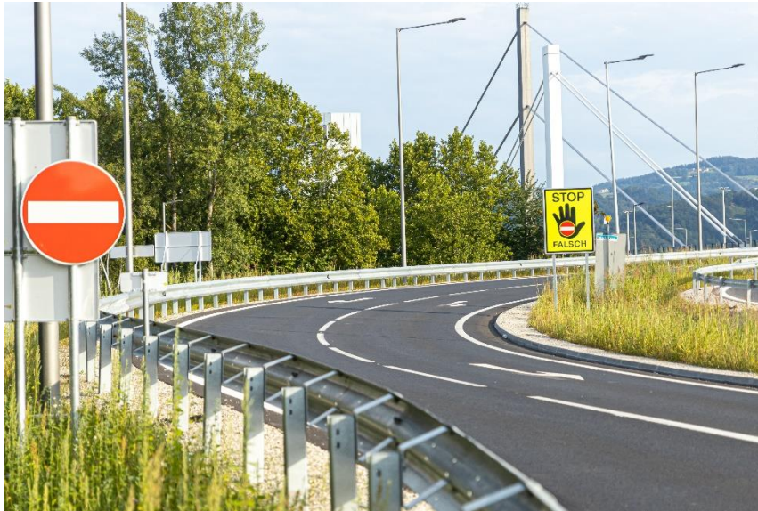
Abb.: Fahrzeugrückhaltesysteme aus Stahl (Leitschienen) auf einer Autobahnabfahrt (Quelle: Wolfsteiner)
